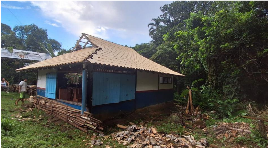
Figura 4 - Reforma do telhado da sede da Associação de Ponta Negra
