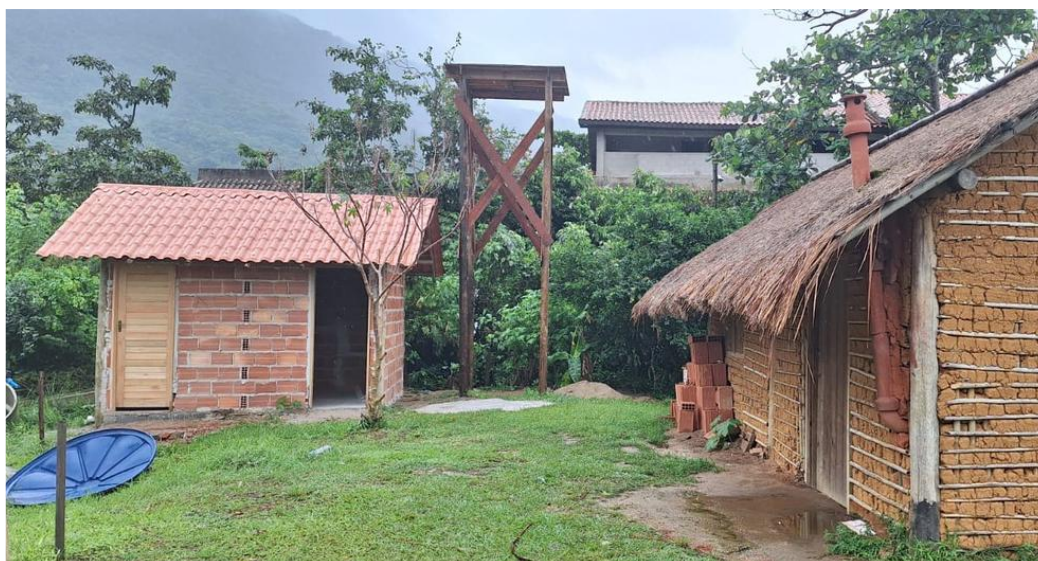
Figura 3 - Construção banheiro na casa de farinha da Associação de Trindade
