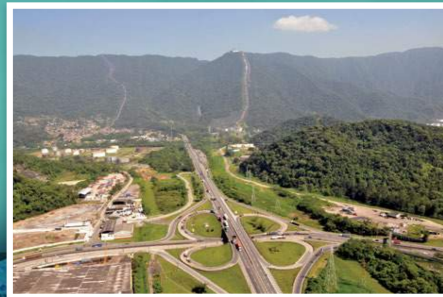
Vista panorâmica do encanamento da Usina Henry Borden a partir da Baixada Santista com a Serra do Mar ao fundo.
