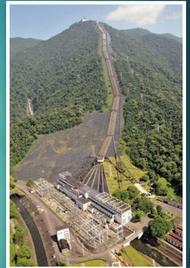
Encanamento da Usina Henry Borden após a passagem das águas do Reservatório Rio das Pedras pelas turbinas na usina.
