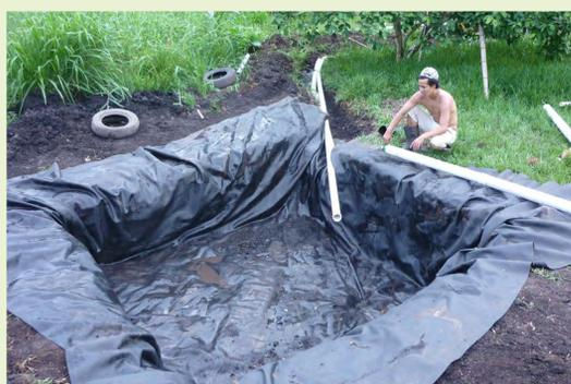
2. O esgoto chega ao fundo deste tanque por meio de um cano com furos, liberando lentamente o
