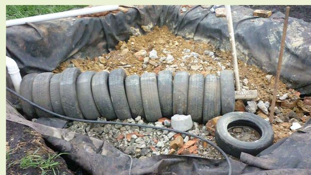
efluente para um tubo feito de pneus velhos enfileirados lado a lado. Neste 1º ambiente dos pneus, ocorre a degradação das fezes por bactérias no processo anaeróbico (sem  $O_2$ ).
